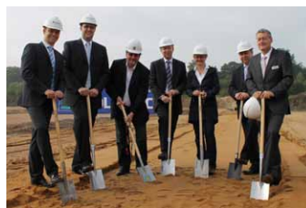
Baubeginn bei Witte Pumps & Technology mit symbolischem ersten Spatenstich
