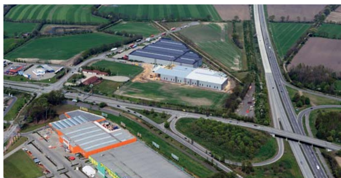
Gewerbegebiet Elmshorn an der A 23
