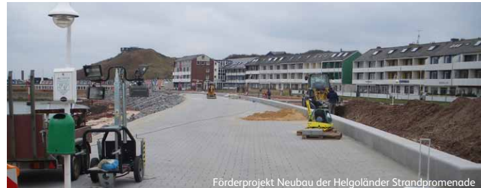
Förderprojekt Neubau der Helgoländer Strandpromenade
