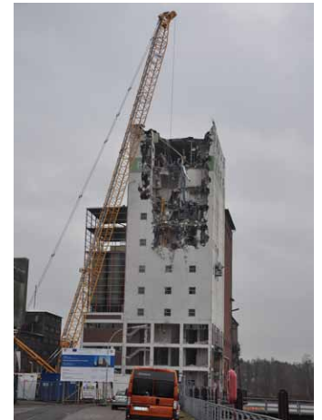
Rund 700.000 Euro Fördergelder für den Abriss des Getreidesilos in Uetersen
